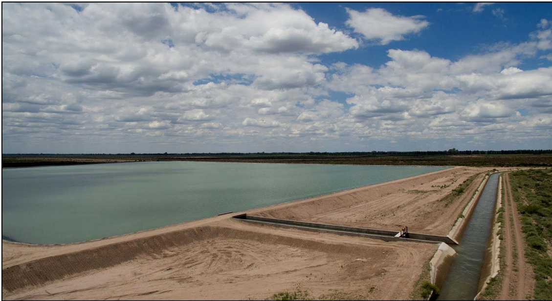
Figura 6. Reservorio modelo implementado por Mendoza dentro del área de riego para almacenamiento y regulación de caudales. General Alvear, Mendoza, abril 2024.
